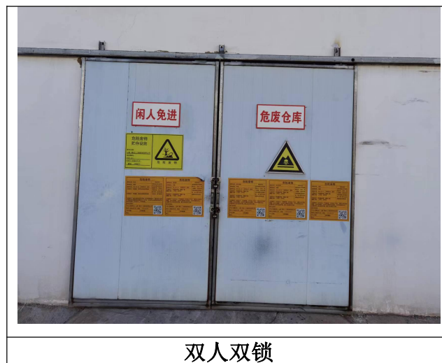
图 4.1-3 危废暂存间图
